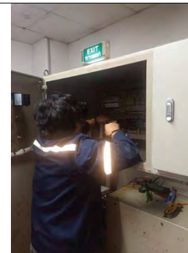
ตัดไฟจากระบบ UPS ต่อตรงเข้าไฟฟ้าโรงงาน และถอด UPS เพื่อนำกลับไปซ่อมตามใบสั่งซื้อเลขที่ PO25-002030
